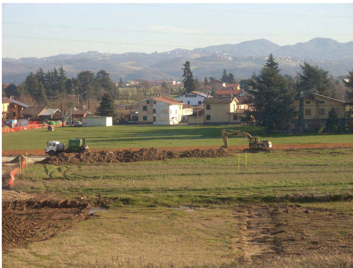
[TAV terzo valico - Cominciano in Basso Pieve (Novi Ligure) i lavori per installare i cantieri e costruire la strada per gli autocarri con lo smarino]
