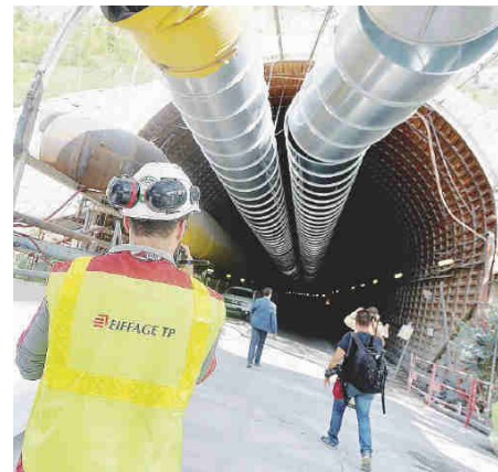
Lavori in corso Il cantiere del Tav Ansa
